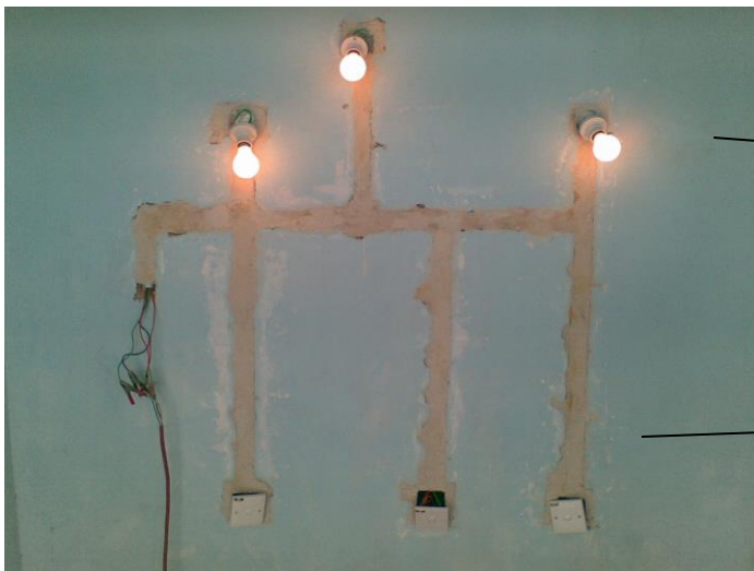
e) Aksesori elektrik dipasang
